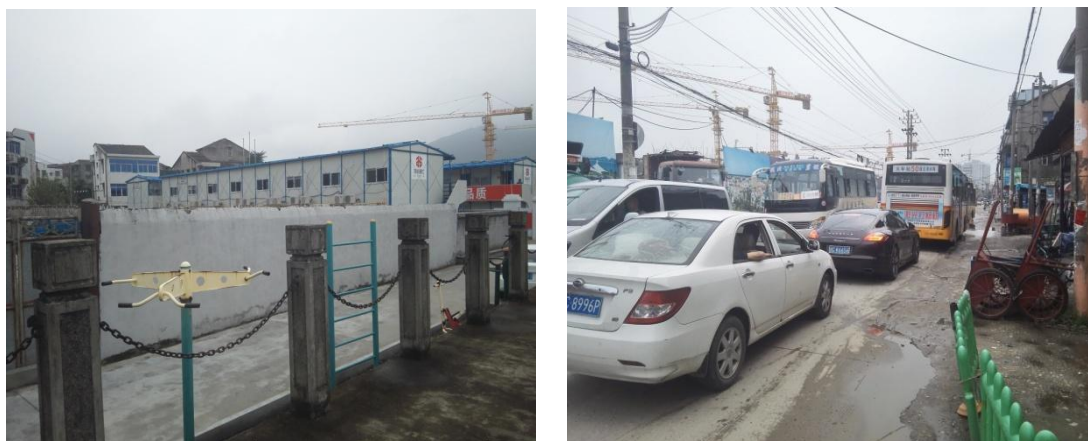
图 1 施工生活区设施及周边交通
